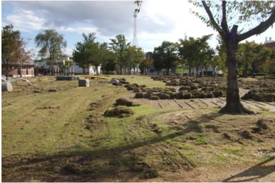
麓山の杜 安積野広場除染（芝生削り）
